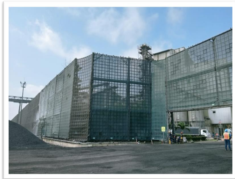
Imagen No 19,20 y 21. Lavado Barrera Ambiental
