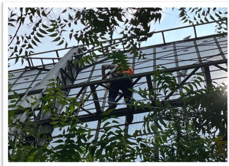
Imagen No 17 y 18. Mantenimiento Barrera Ambiental
