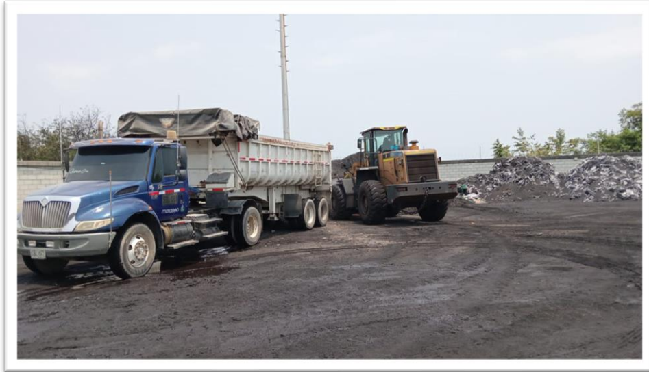
Imagen No 28. Material de raspe retirado por el tercero MAR ASEO
