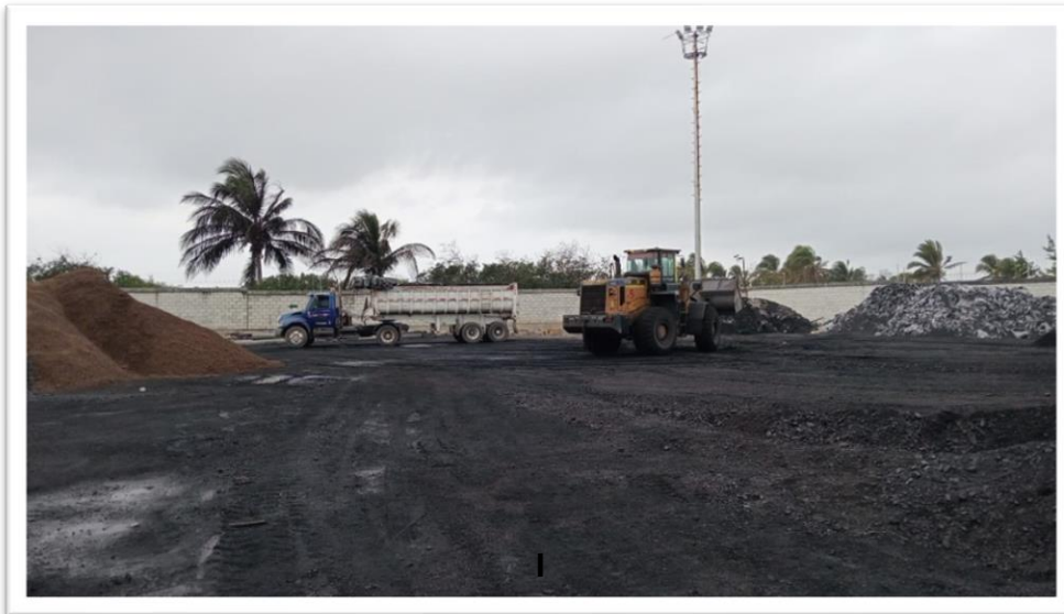
Imagen No 29. Material de raspe retirado por el tercero MAR ASEO
