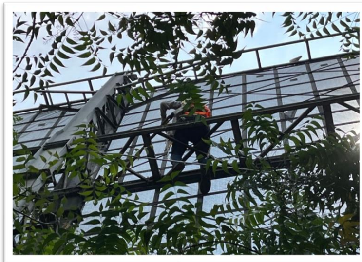
Imagen No 17 y 18. Mantenimiento Barrera Ambiental
