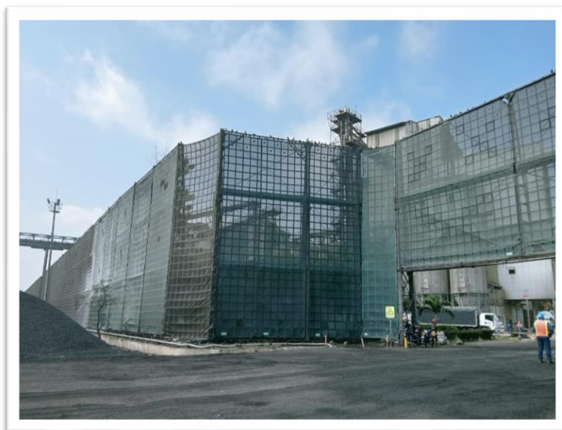
Imagen No 19,20 y 21. Lavado Barrera Ambiental
