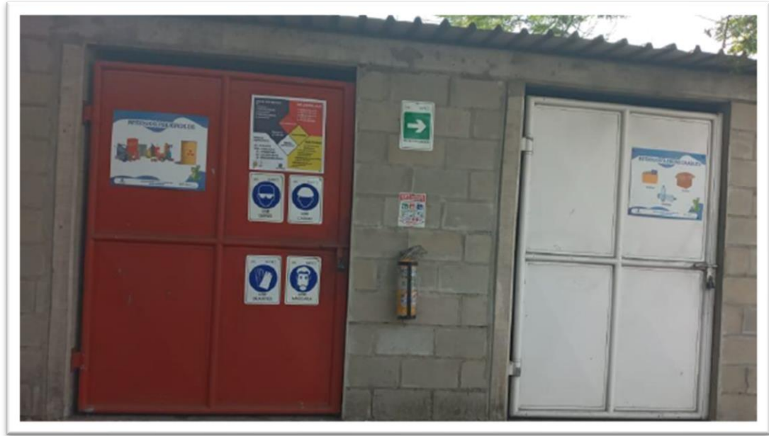
Imagen No 27. Centro de Acopio de residuos Riverport.
