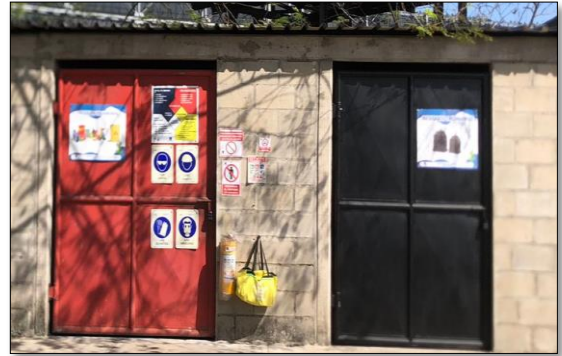
Imagen 3. Centro de acopio, compartimientos para ordinarios y Respel
