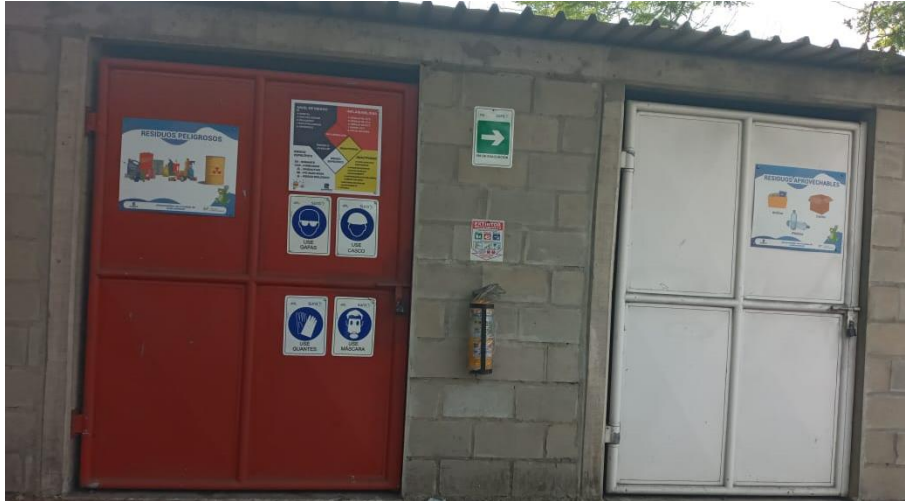
Imagen 81. Centro de acopio de Riverport.
