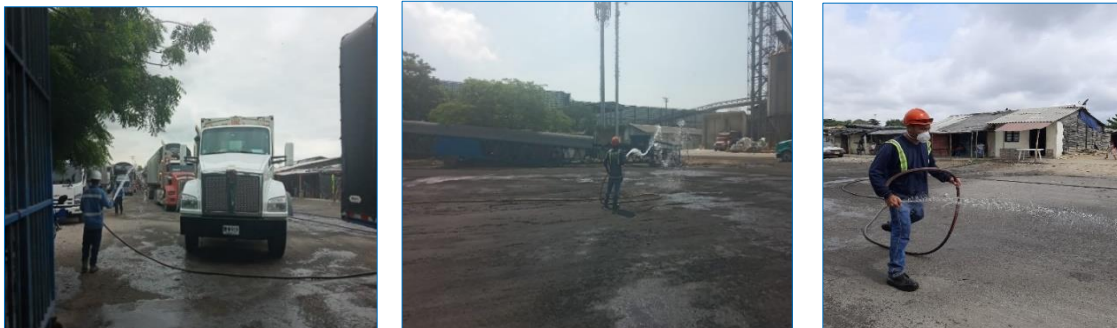
Imagen 5. Riego de vías internas y externas.
