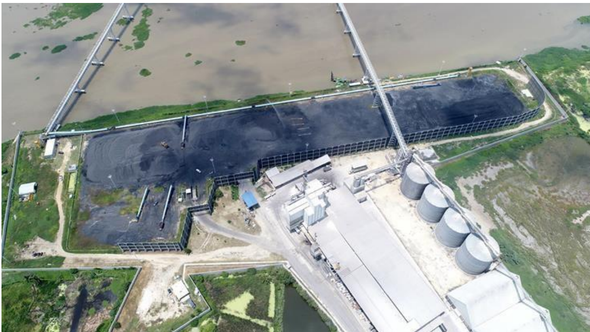
Imagen 1. Infraestructura del terminal portuario RIVERPORT S.A.
